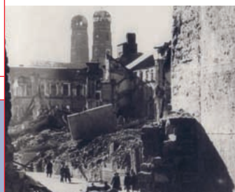
München, zerstörte Stadt.
